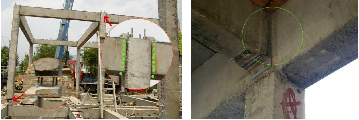
ภาพที่ 1 แสดงรอยต่อของชิ้นส่วนคานต่อกับคานเสาที่สอบถามผ่านชุมชนออนไลน์
