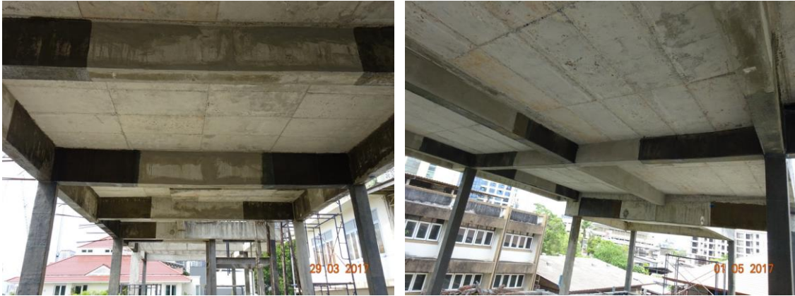
รูปที่ 8 การติดตั้ง Carbon Fiber Reinforced Polymers
