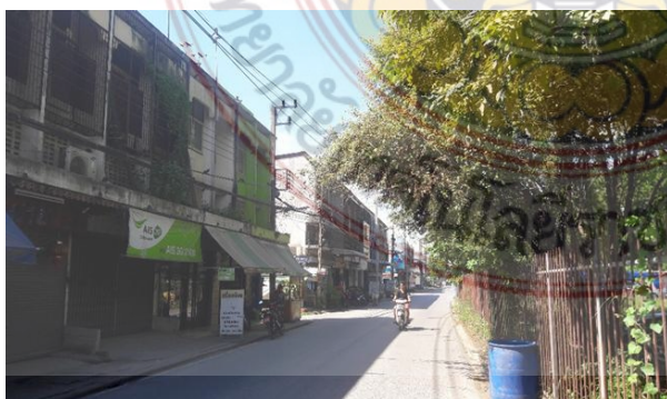
รูปภาพที่ ๕.๕๓ ภาพก่อนปรับปรุงอาคาร Mix Used
