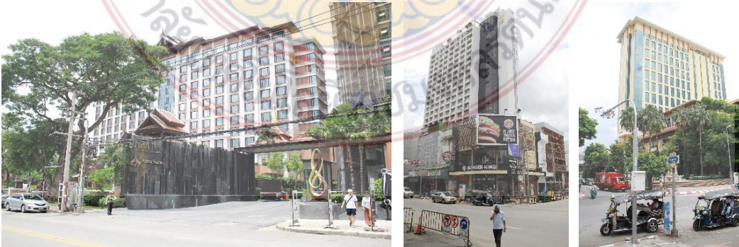
รูปที่ ๓.๑๗ อาคารที่พักอาศัยแนวตั้ง ที่มา: จากการสำรวจ พ.ศ. ๒๕๖๐
