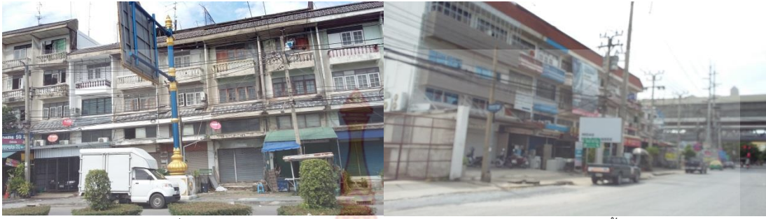
ภาพที่ ๓.๘ การใช้ประโยชน์อาคารบริเวณริมถนนนทบุรี๑(สนามบินน้ำ) ที่มา : จากการสำรวจ
