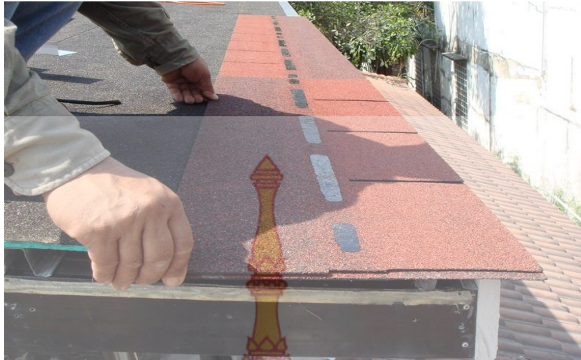
รูปที่ 2.14 วิธีการปูแผ่น starter
