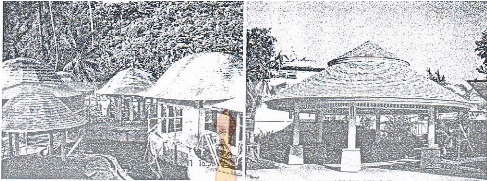
รูปที่ 2.19 ตัวอย่างงานที่ใช้ Asphalt Shingles
