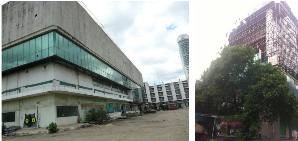
รูปที่ 1 สภาพอาคารเดิมก่อนการปรับปรุง
