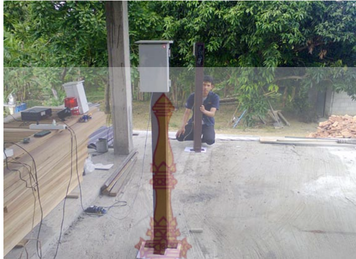
ภาพที่ 117 การเปลี่ยนทิศทางการวางสาย ทำการจัดมุมที่ 15 องศา ในการตรวจจับ Infrared Sensor
