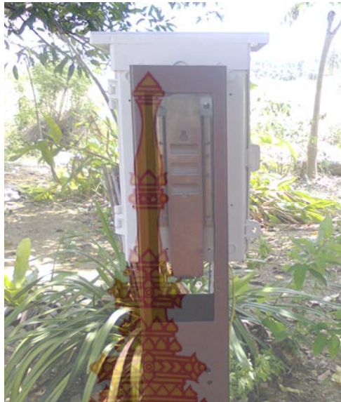
ภาพที่ 98 ติดตั้งกล่องควบคุม Infrared Sensor กับเสาจำลอง 3.14 ติดตั้งอุปกรณ์ Infrared Sensor กับเสาจำลอง
