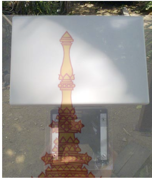
ภาพที่ 100 ติดตั้งแผ่นอะคริลิกใสด้านหลังป้องกันฝุ่นละอองและสิ่งแปลกปลอม
