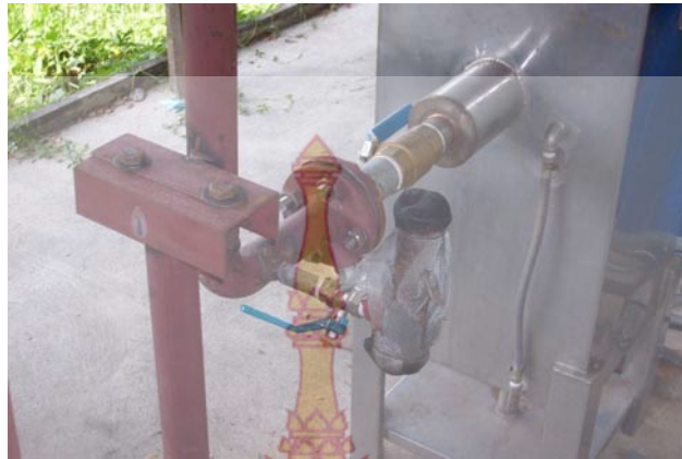
ภาพที่ 31 หัวสำหรับจุดทดสอบแก๊ส
