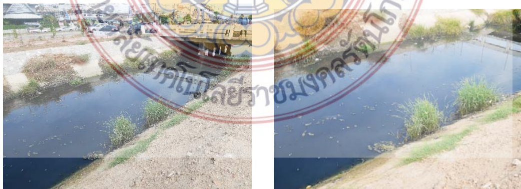
ภาพที่ 30 สภาพแวดล้อมบริเวณของที่ตั้งโครงสร้างสะพานที่ 1 อำเภอหัวหิน
