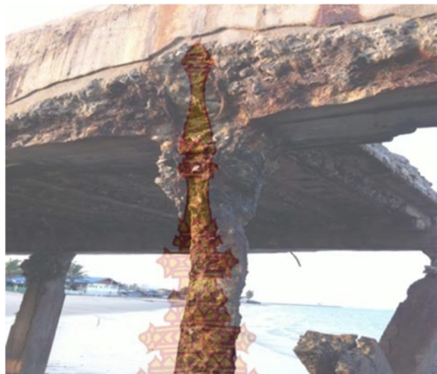
ภาพที่ 1 ผลกระทบเนื่องจากคลอไรด์ในโครงสร้างคอนกรีต (สะพานปลา อำเภอบรามบุรี)
