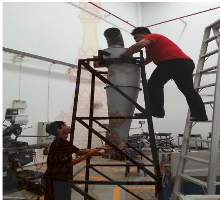
ภาพที่ 3-26 ติดตั้งถังไซโคลน
