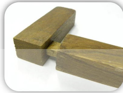
ภาพที่ 2-1 แสดงถึงการเข้าเดือยปากชน ( โครงการสร้างต้นแบบเพื่อจัดทำองค์ความรู้ด้านงานศิลปกรรม ความรู้ทางด้านงานช่างแกะสลักและงานช่างไม้ประณีต, 2523 : 123 )
