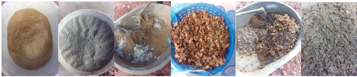
รูปที่ 2: การผสมถุงปูนซีเมนต์ตามอัตราส่วน
