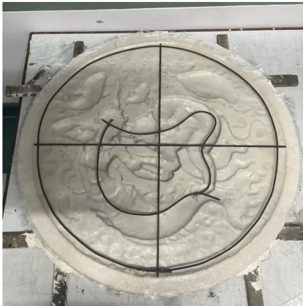
ภาพที่ 3.105 ภาพแสดง : ลงโครงเหล็ก
