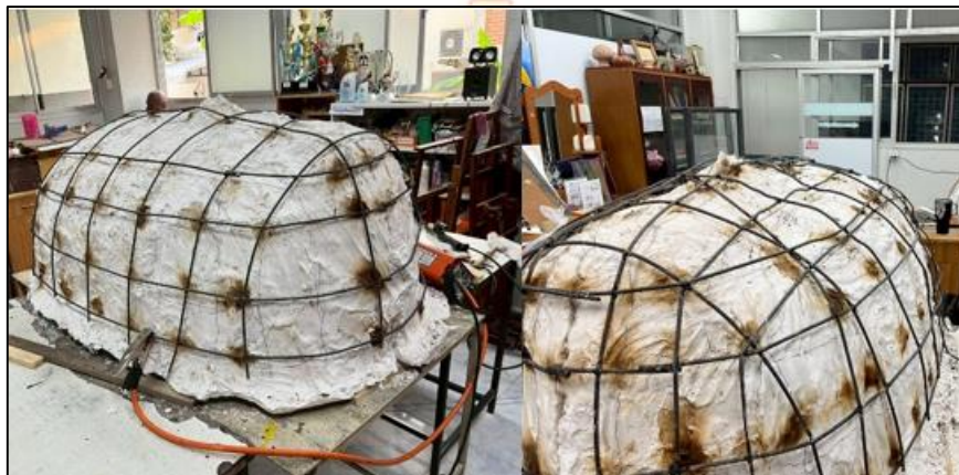
ภาพที่ 3.18 ภาพแสดง : การใส่โครงสร้างด้วยเหล็ก
