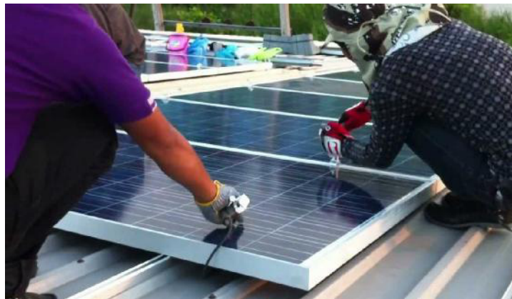
รูปที่ 5 การติดตั้งโซลาร์เซลล์ชนิดผลึกผสม (Poly crystalline) บริเวณหลังคาบ้านลอยน้ำ
