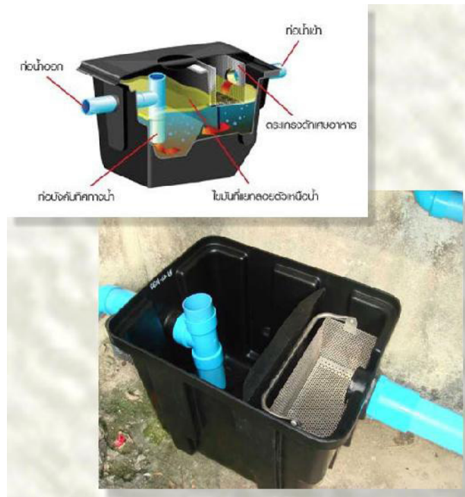
รูปที่ 6 การติดตั้งถังบำบัดน้ำเสียบริเวณบ้านลอนานี้
