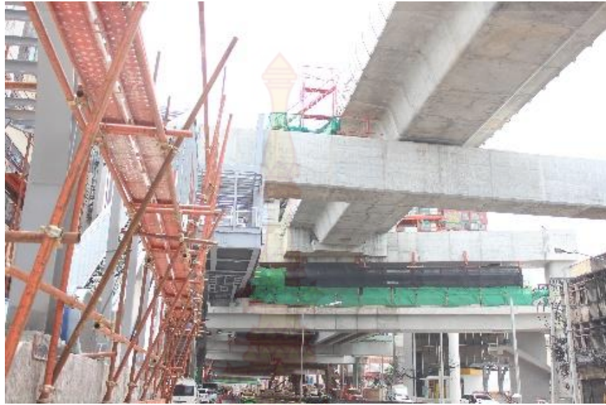
ภาพที่ 20 : การก่อสร้างสะพาน ที่มา : ข้อมูลจากผู้เขียน
