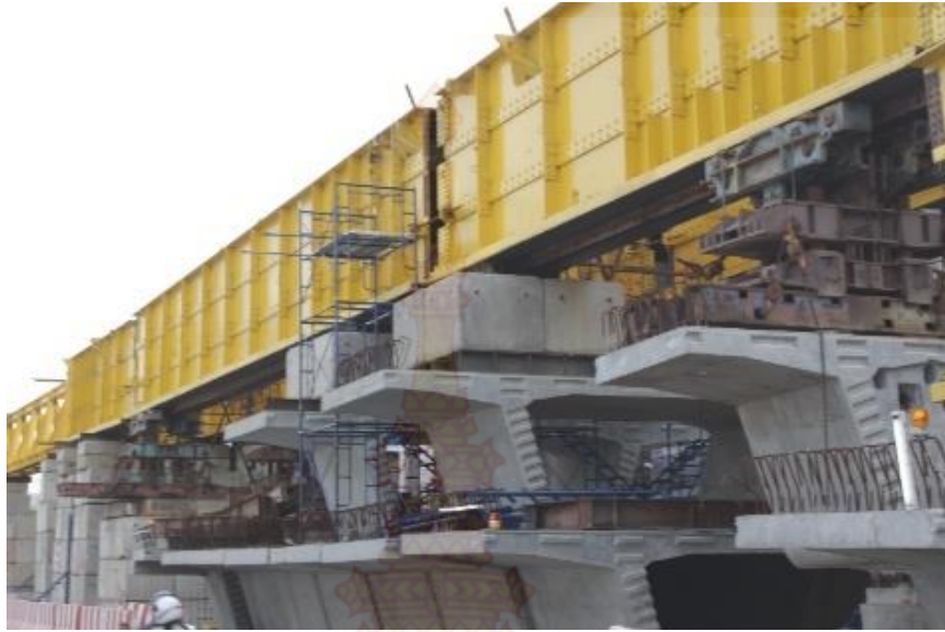
ภาพที่ 16 : โครงสร้างเหล็ก ที่มา : ข้อมูลจากผู้เขียน
