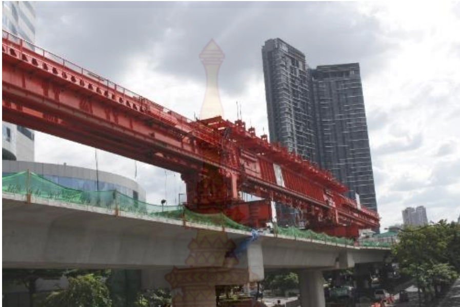
ภาพที่ 18 : การก่อสร้างสะพาน ที่มา : ข้อมูลจากผู้เขียน
