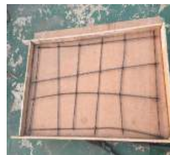
3.ทำโครงเหล็ก
