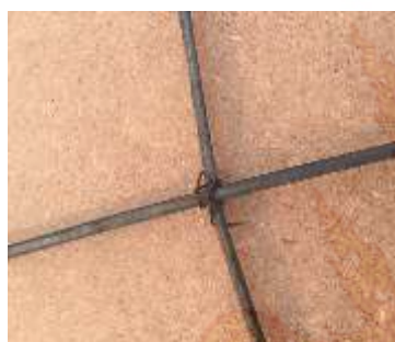
4.มัดโครงเหล็ก
