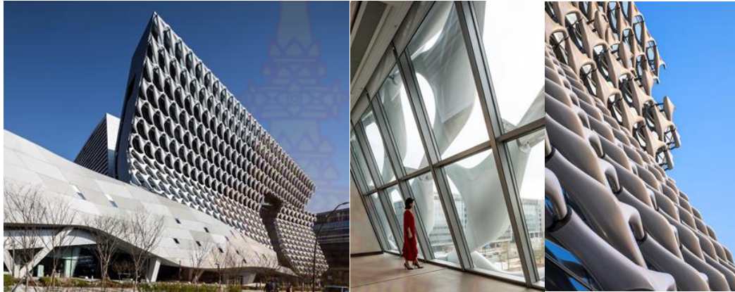
ภาพที่ 6 Shading device ช่วยบังแดดให้กับผนังอาคาร
