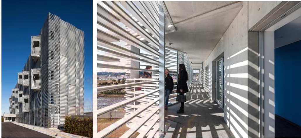
ภาพที่ 4 การใช้ผนังครีปในการบังแดดให้ผนังอาคาร
