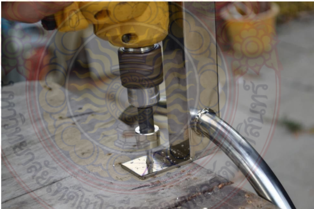
ภาพที่ 24 การเจาะแป้นยึดเพื่อยึดคอนเนคเตอร์
