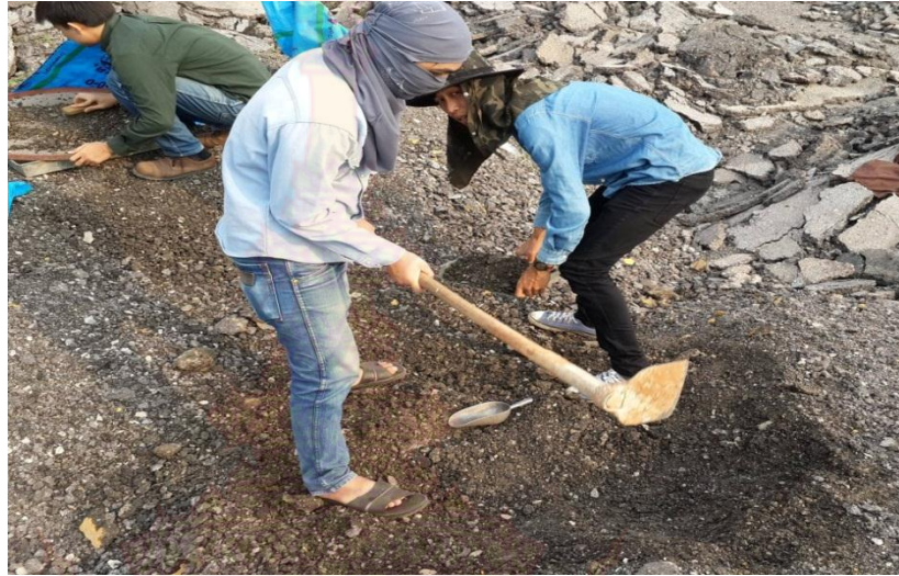
ภาพที่ ค-1 การเตรียมวัสดุชั้นทางเดิมเสื่อมคุณภาพ จากสำนักงานบำรุงทางธนบุรี
