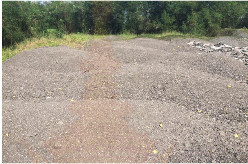
ภาพที่ 3-1 ลักษณะของชั้นทางเดิมเสื่อมคุณภาพ
