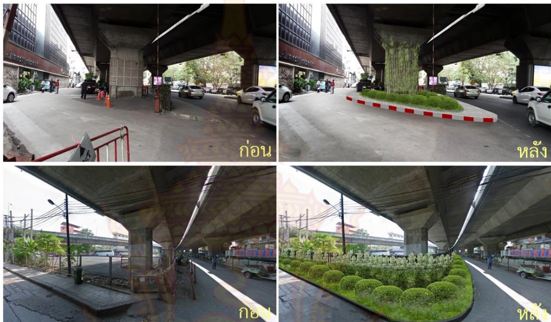
ภาพที่ 4.27 การปลูกพืชพันธุ์ให้ต่อเนื่องเป็นแนวยาวหรือเป็นผืน ในพื้นที่ว่างเขตทาง บริเวณใต้ทางด่วน
