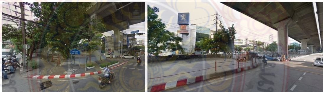
ภาพที่ 4.34 สภาพพื้นที่ว่างใต้ทางด่วนศรีรัช บริเวณถนนพระราม 4 แยกถนนมหานคร
