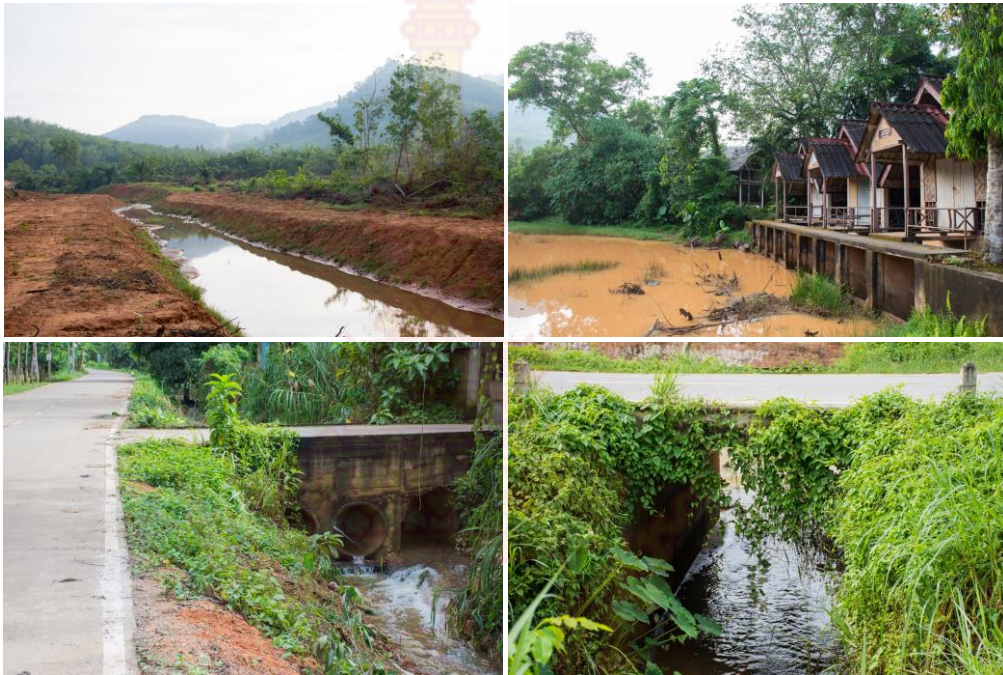
(บน) คลองขุดและฝายกักเก็บน้ำคอนกรีตเพื่อรองรับน้ำจากภูเขาสูง (ล่าง) คลองขุดช่วงไหลผ่านชุมชนก่อนไหลลงคลองหะ
