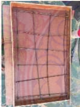
7.วางโครงเหล็ก
