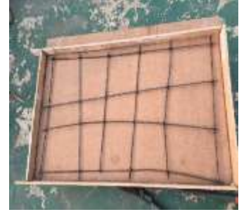
3.ทำโครงเหล็ก
