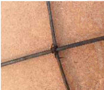
4.มัดโครงเหล็ก
