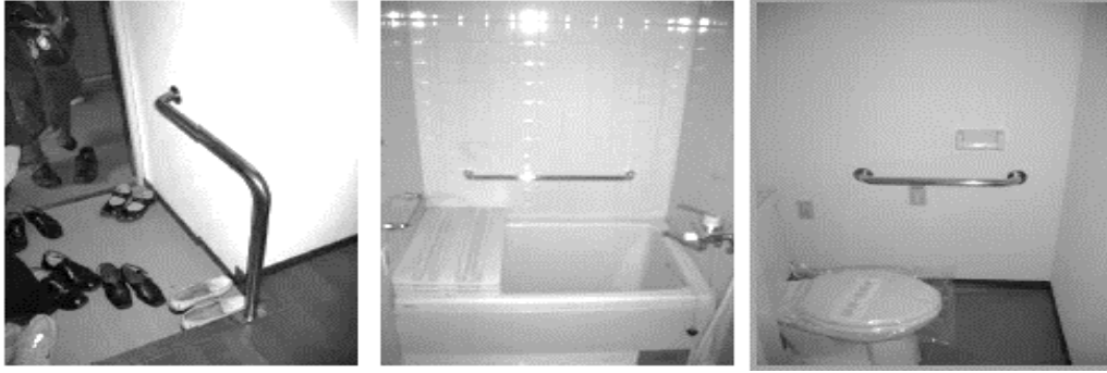
รูปที่ 3 แสดงอุปกรณ์ราวช่วยพยุงติดไว้เพื่อความปลอดภัยของผู้ใช้งาน (ที่มา: http://www.pwdsthai.com/files/universal_design.pdf )
