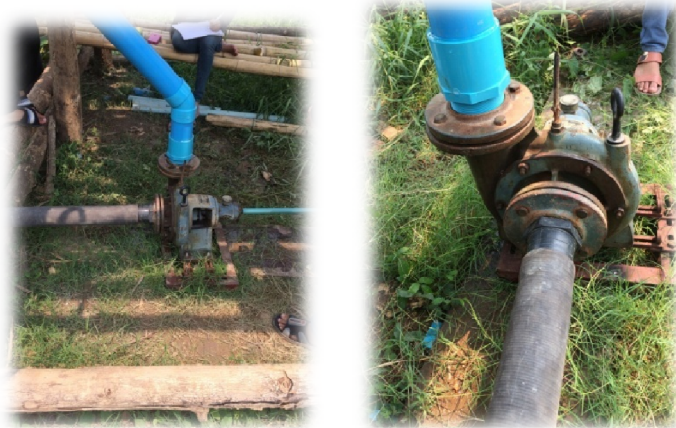
รูปที่ 3 การติดตั้งกั้นน้ำเข้ากับระบบประปาหมู่บ้านเพื่อผลิตไฟฟ้า
