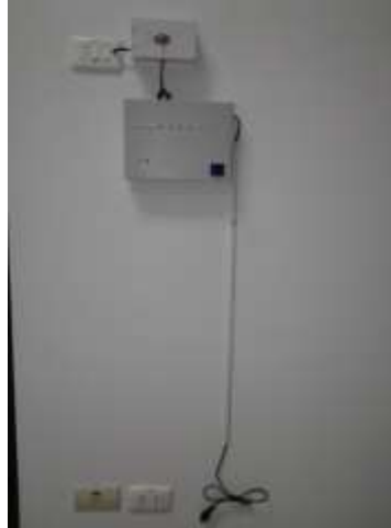
รูปที่ 5 การติดตั้งกล่อง relay กับระบบไฟฟ้าเดิมที่มีอยู่
