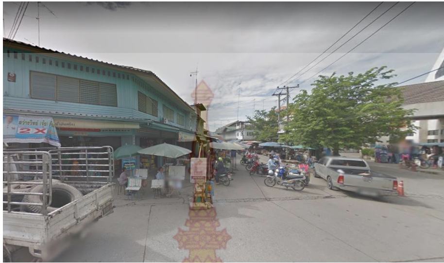
ภาพก่อนปรับปรุง
