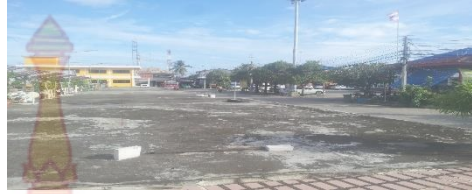
ภาพก่อนปรับปรุง
