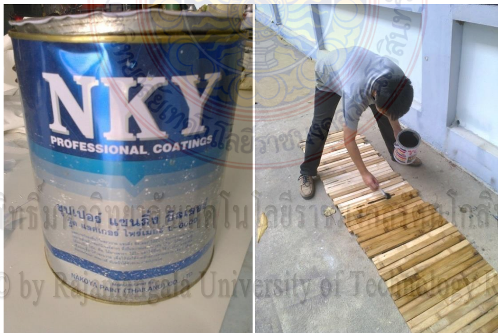
ภาพที่ 3-21 แสดงน้ำยา ซิลเลอร์ ทาเคลือบผิวไม้
