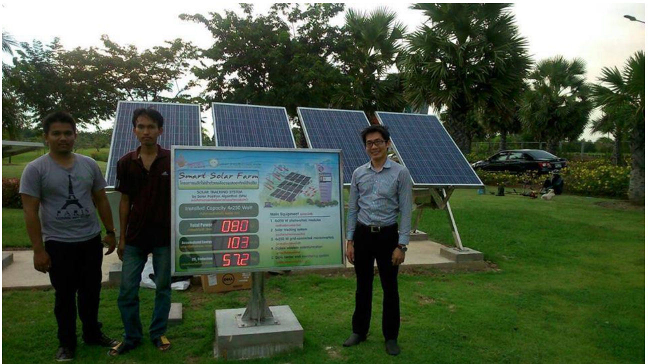
รูปที่ 14: ระบบต้นแบบที่ทำการติดตั้งเพื่อทดสอบการทำงาน
