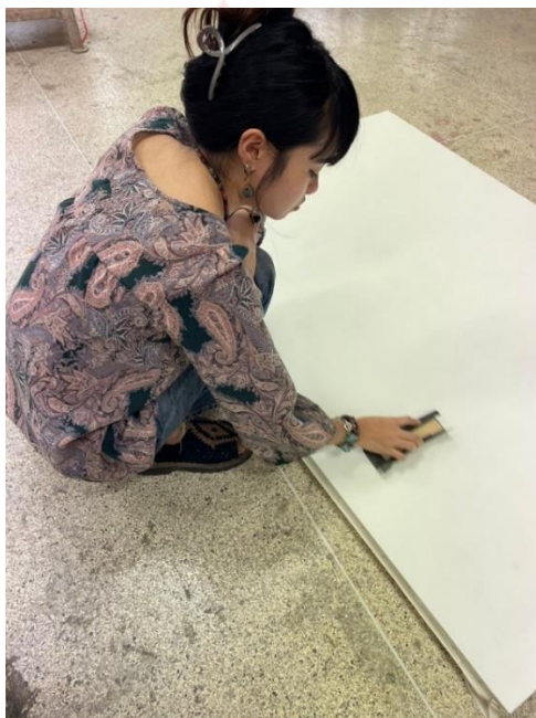
ภาพที่ 56 แสดงการขัดพื้นให้เรียบเนียนใช้กระดาษทรายเบอร์กลาง ตามด้วยเบอร์ละเอียด ข้อมูลจาก : นางสาวนัทธ์ชนัน จิตจำ, เมื่อวันที่ 27 มกราคม 2567
