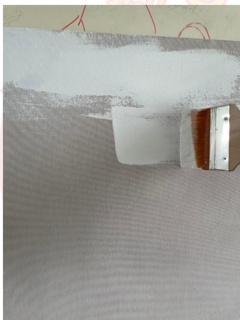
ภาพที่ 55 การทาสีรองพื้นสีขาวพลาสติก 2 ชั้น เพื่อความเรียบเนียน ข้อมูลจาก : นางสาวนัทธ์ชนัน จิตจำ, เมื่อวันที่ 27 มกราคม 2567
