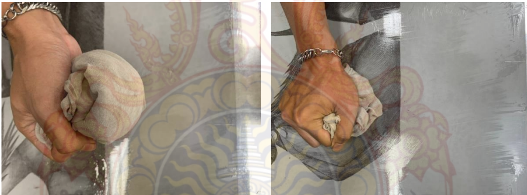
ภาพที่ 39 ภาพขั้นตอนการกัดกรด โดยวิธีใช้แปรงจุ่มกาววนสลับกันไป-มา ที่มา : ข้อมูลจากผู้เขียน
