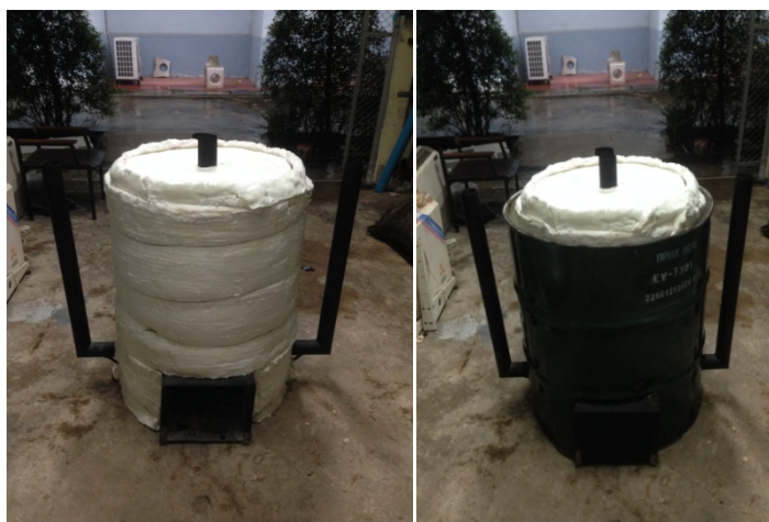
รูปที่ 4 การติดตั้งฉนวนเซรามิกซีโฟเบอร์รอบเตาเผาถ่าน 200 ลิตร
