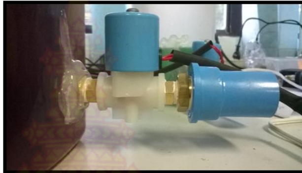
ภาพที่ 30 ติดตั้ง SOLENOID VALVE (โซลินอยด์) 2 หุน 220V ตัวที่ 1
