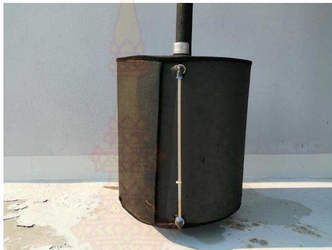
ภาพที่ 3-3 หุ้มฉนวนกันความร้อนที่ถังบรรจุสารละลายน้ำมันหอมระเหย
