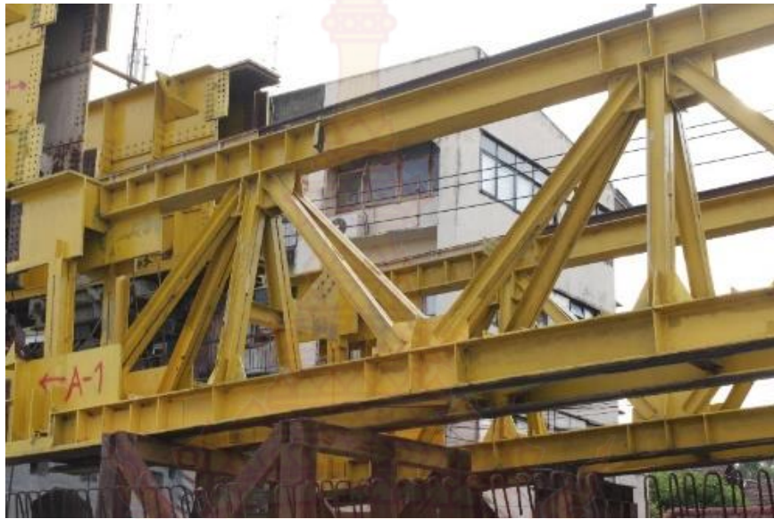
ภาพที่ 14 : โครงสร้างเหล็ก ที่มา : ข้อมูลจากผู้เขียน
