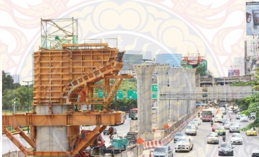
ภาพที่ 21 : การขึ้นโครงสร้าง ที่มา : ข้อมูลจากผู้เขียน
