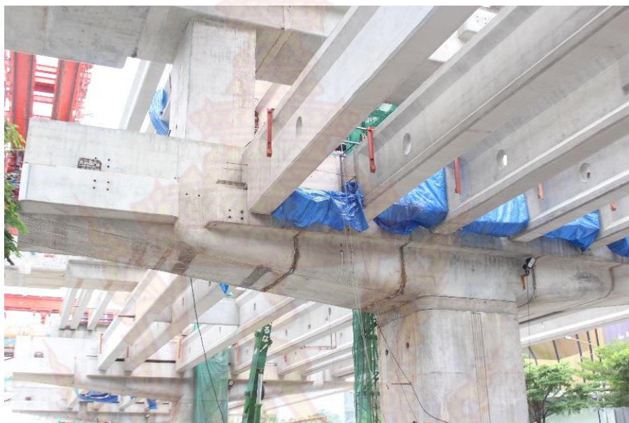
ภาพที่ 5 : การก่อสร้างของสะพาน ที่มา : ข้อมูลจากผู้เขียน
