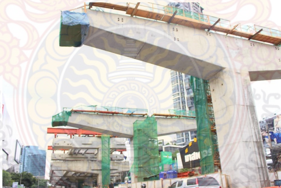
ภาพที่ 11 : ภาพการก่อสร้างสะพาน ที่มา : ข้อมูลจากผู้เขียน
