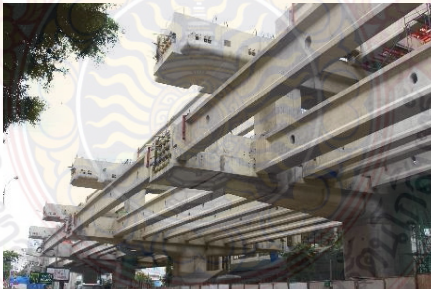
ภาพที่ 13 : โครงสร้างสะพาน ที่มา : ข้อมูลจากผู้เขียน
