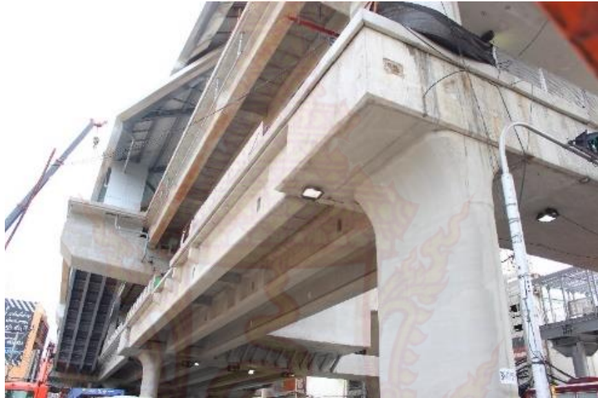
ภาพที่ 12 : การก่อสร้างสะพาน ที่มา : ข้อมูลจากผู้เขียน
